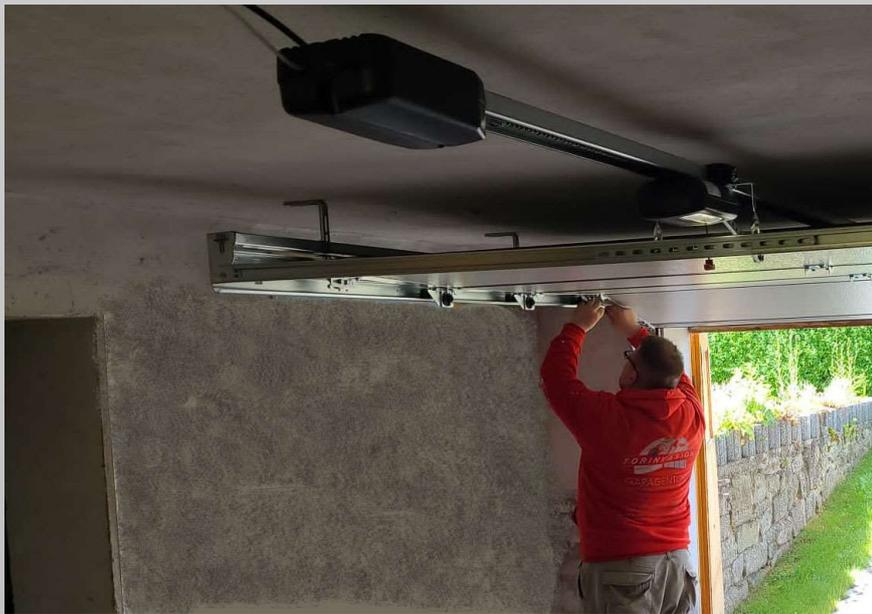
Vorkonfektionierte Bauteile und eine übersichtliche Montageanleitung erleichtern den Aufbau Ihres neuen Tores maßgebend. Durch die bereits in der Bodensektion integrierte Bodendichtung wird ein umständliches Anbringen vermieden.
